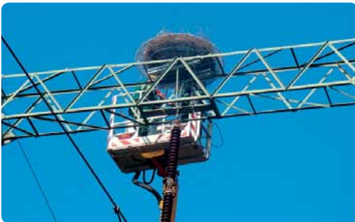
Fot. 9b. Montaż sztucznego gniazda na słupie trakcji wysokiego napięcia
