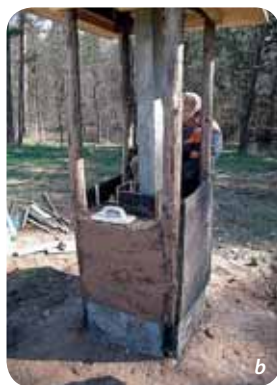
Fot. 19 a, b, c. Sposób wykonywania glinianej konstrukcji
