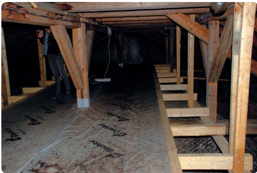
Fot. 17. Platforma to niekiedy pokaźna konstrukcja, wymagająca projektu budowlanego i uzyskania pozwoleń
