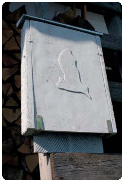
Fot. 13. Natynkowa skrzynka cementowo-ceramiczna marki Mitra, przeznaczona do umieszczenia na elewacji budynków. Istnieje również wersja podtynkowa tej skrzynki, przeznaczona do wbudowywania w elewację Fot. A. Rachwald
