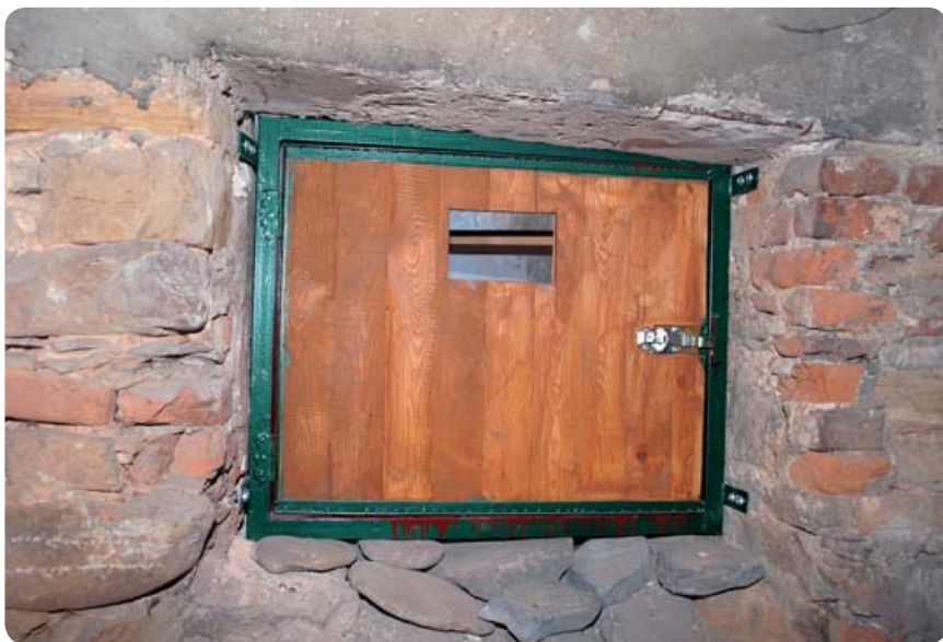
Fot. 19. Oddzielenie przestrzeni schronienia nietoperzy od trasy turystycznej na zamku w Niedzicy
