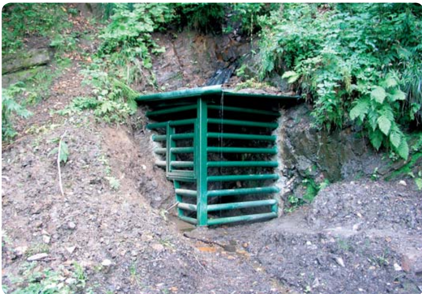
Fot. 12. Krata zabezpieczająca jaskinię
