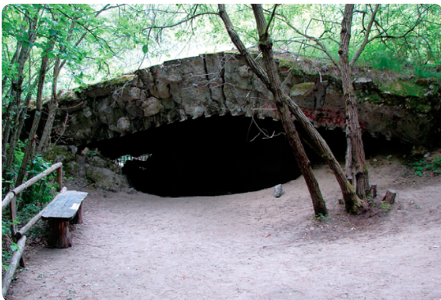
Fot. 26a. Bunkier w Strzalinach – widok na wejście
