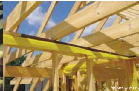
Fragment konstrukcji budynku
