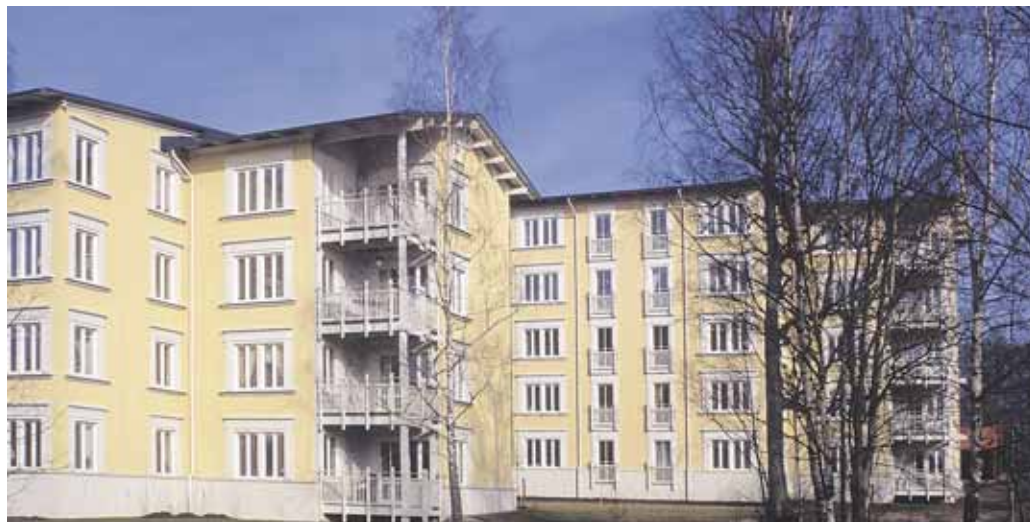
Pięciokondygnacyjny budynek o drewnianej konstrukcji szkieletowej w Szwecji
