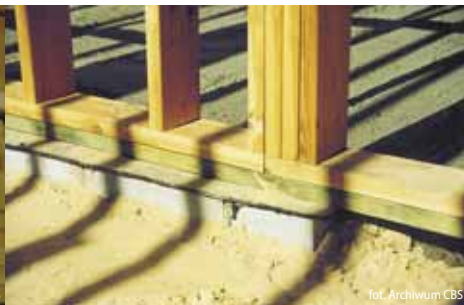
Podwalina impregnowana ciśnieniowo
