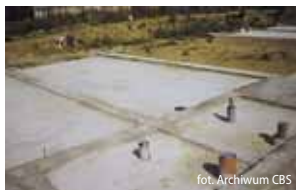
Płyta fundamentowa pod dom drewniany
