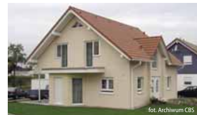
Tynk na styropianie lub wełnie
