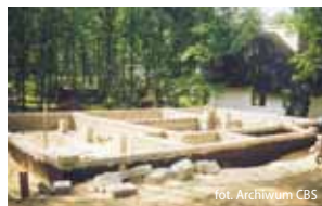
Ściany fundamentowe pod strop z pustką podpodłogową
