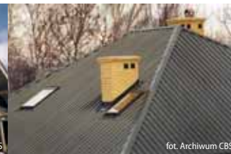
Pokrycie z blachy
