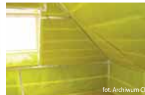
Ściany i dach pokryte folią paroizolacyjną
