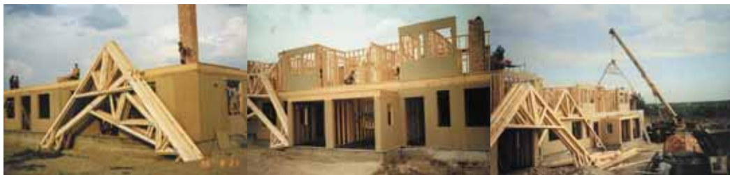
Montaż domu w systemie prefabrykacji otwartej
